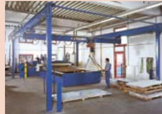
Aufgeständertes Kran-System (Vetter Fördertechnik)
